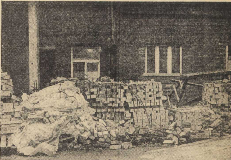
Zupełnie nowa forma składowania materiałów budowlanych przy budynku polekarek.
