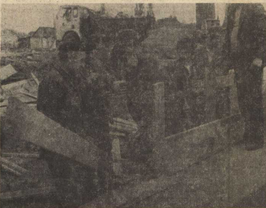
Budowa nowej szkoły — pracownicy Celulozowni przy montażu oszalowań.
