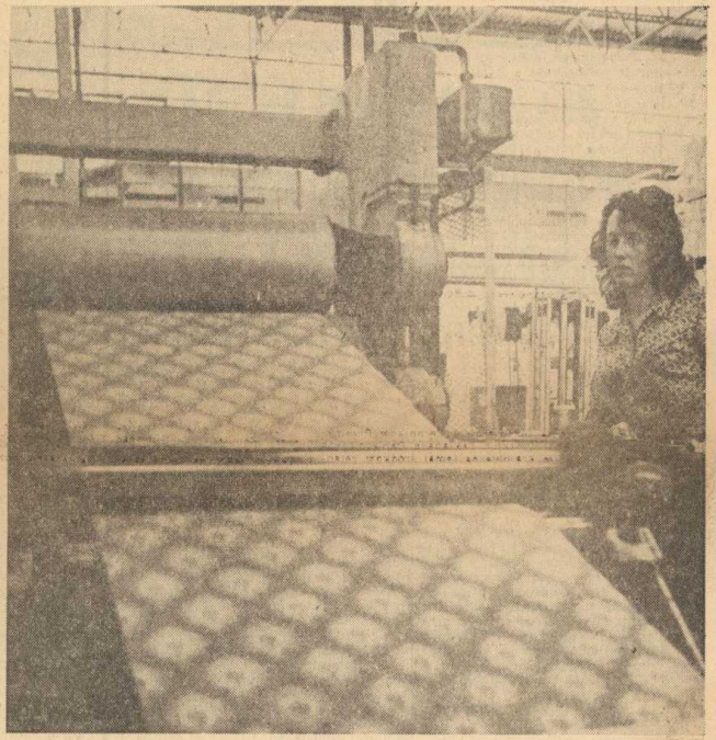
Ostatnia operacja przy produkcji tapet — wycinanie faktury
